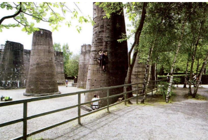
拆除顶盖的矿石料仓改造成攀岩场地
