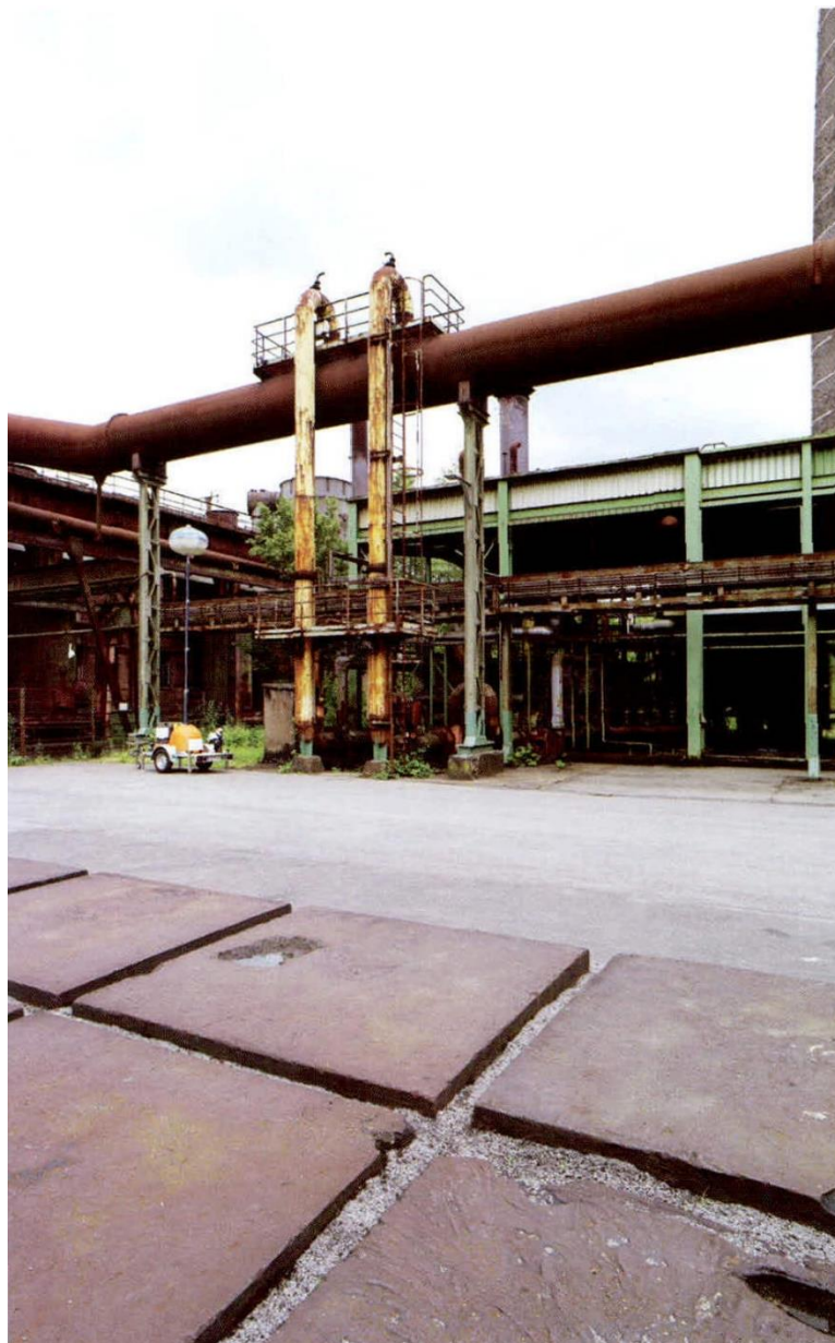
废旧钢板改造的铺装
